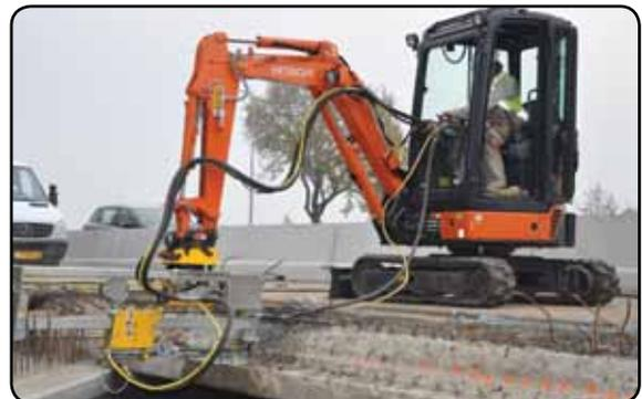
**Große Reichweite durch den Löffelstiel vom Bagger und die 360° Rotation des Bohrlafettes.**
